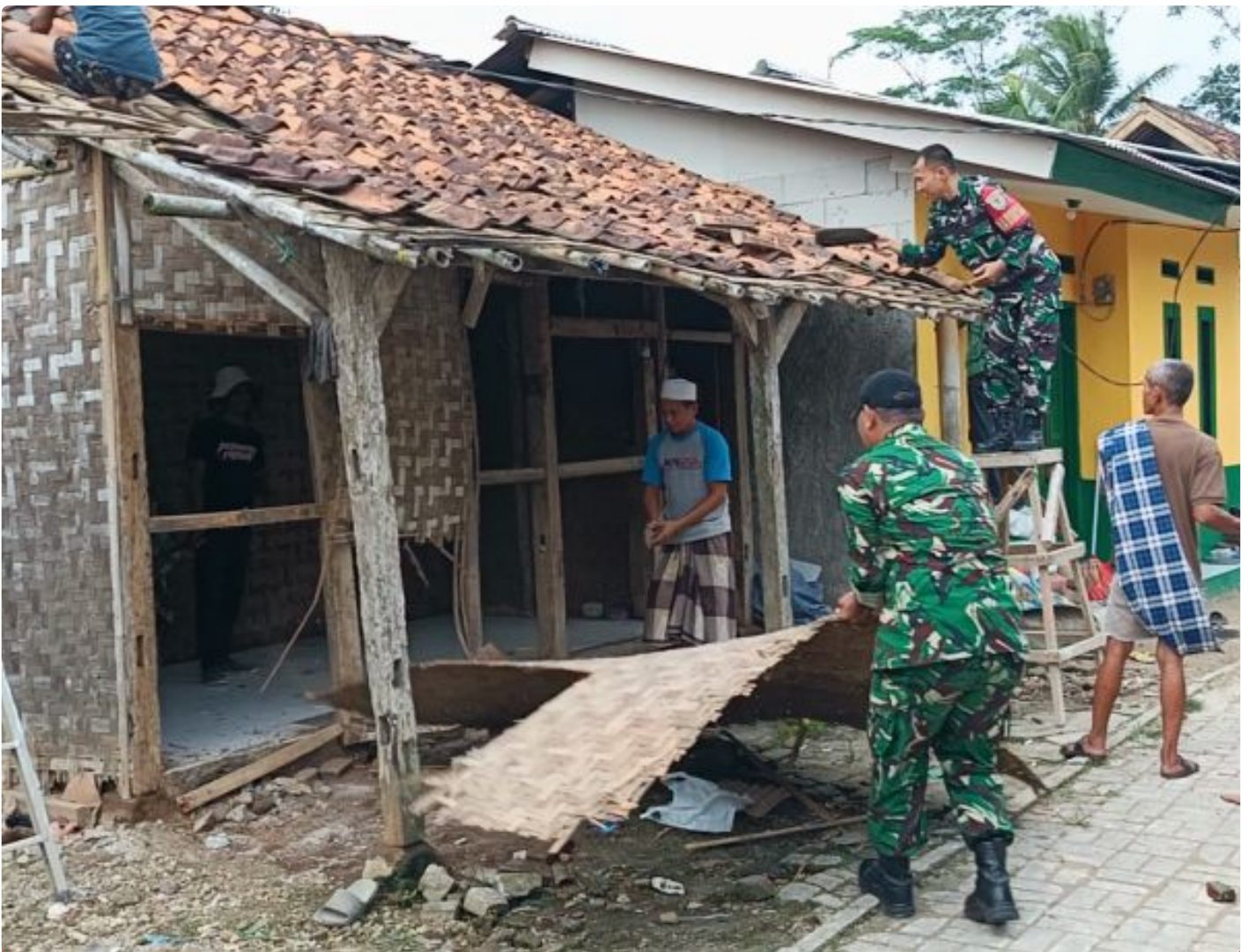
Pembongkaran Rumah Bapak Narmin
